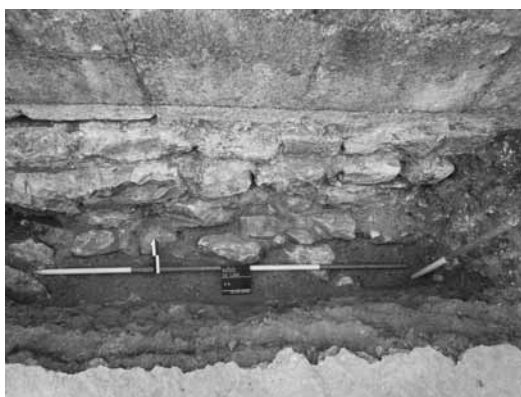
Sl. 10. Temeljna stopa zida crkve iz 14.-15. st. otkrivena uz južni vanjski zid crkve Sv. Luke iz 18. st. (foto: Marinko Tomasović)
